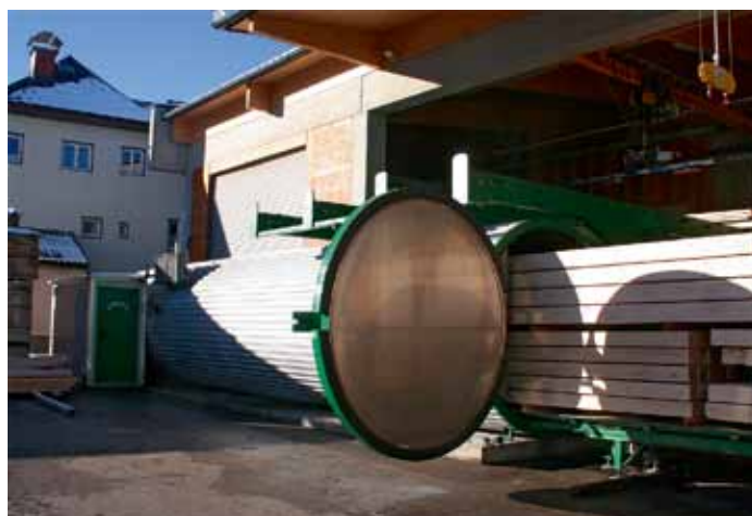
Der Platzproblematik begegnete Eberl mit einer maßgeschneiderten Lösung inklusive Erhöhung der Gleisanlage
