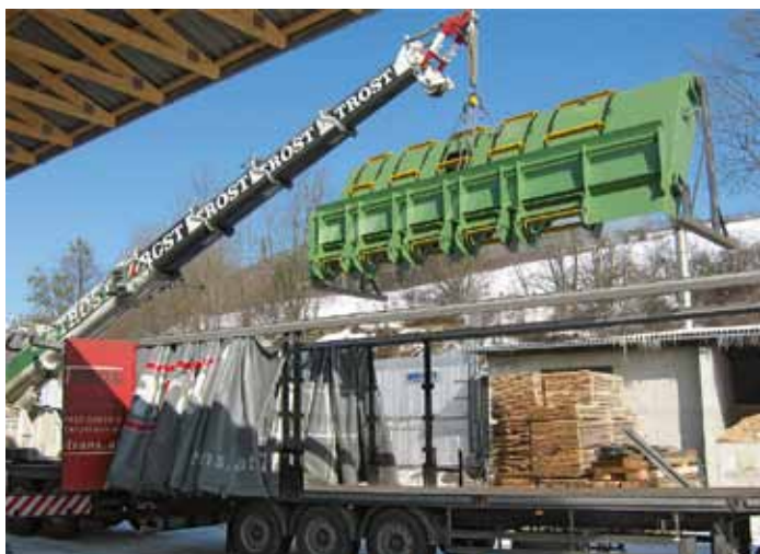
Einsatz von schwerem Gerät bei der Montage des Lause-Vereinzelungsförderers
