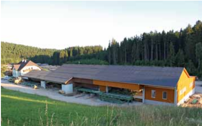
Blick auf die Mechanisierung und Zuführung von Mayrhofer vor der Paul-Nachschnittkreissäge
